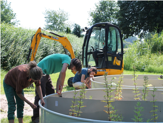
Aufbau & Bepflanzung der Versuchsbecken im Juli 2017
